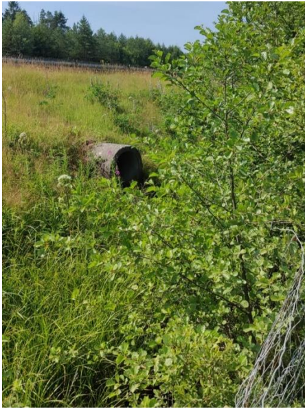
Figur 7. Trumma DN800BTG under riksväg 40.
